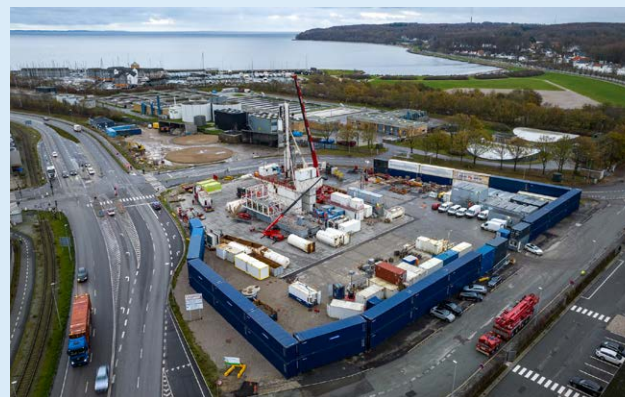
Borearbejdet i gang på Sumatravej - 2023
